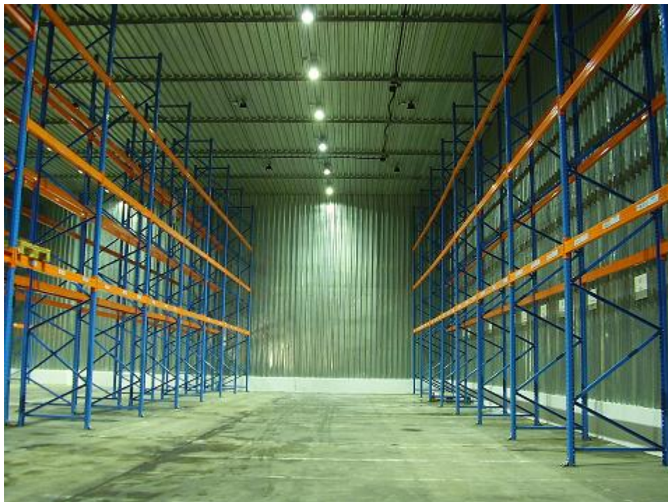
Obr.2: Osvětlení skladovací haly svítidly s LED zdroji 36W.
