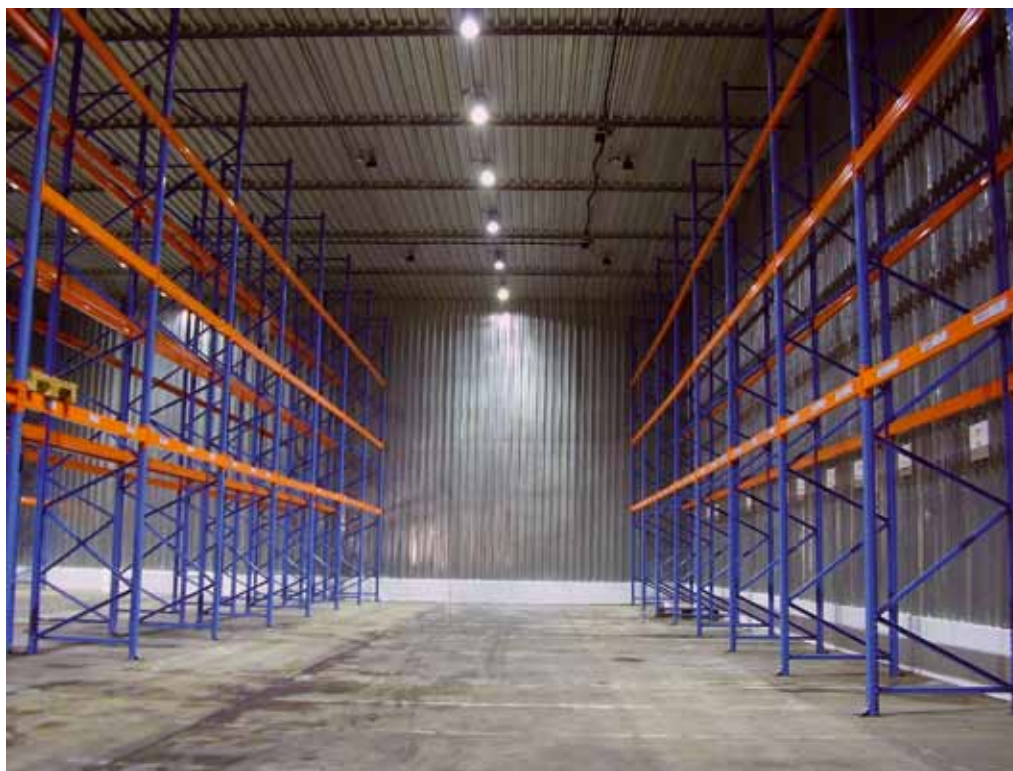
Obr.2: Osvětlení skladovací haly svítidly s LED zdroji 36W.
